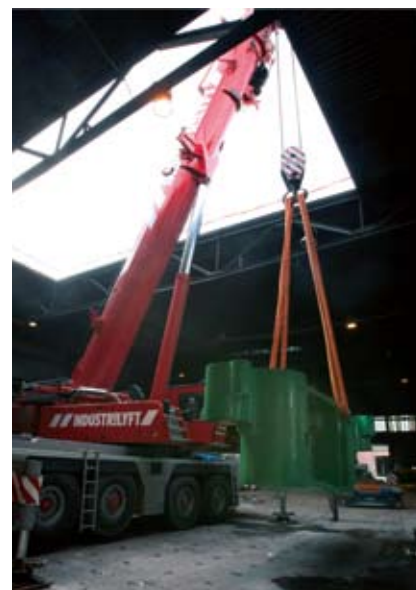
Den nya smidespressen under konstruktion i Hagfors
