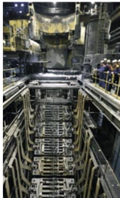
SSAB Tunnpå. Moderniserad stränggjutningsmaskin för tillverkning av avancerade höghållfasta stål.
