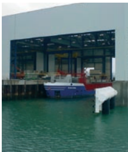
SSAB Tunnsplåts nya distributionsplattform i Rotterdam.
