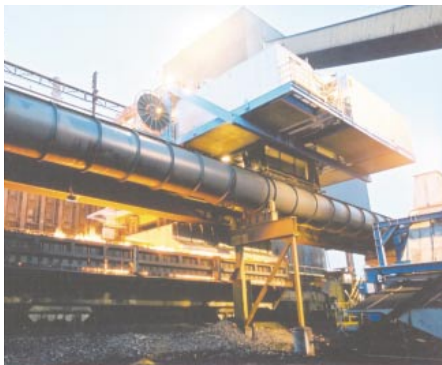
Koksverket i Luleå med sin nya mobila huv.
