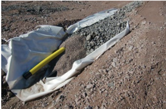
Bild 28 Fördröjningsmagasin av grov slagg ovanpå dräneringslager och rör. Foto: Björn Haase, Höganäs AB
