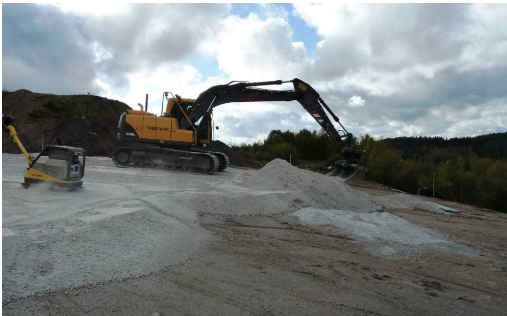
Figur 18 Utläggning av slagg för tätskiktet ovanpå avjämningskiktet
