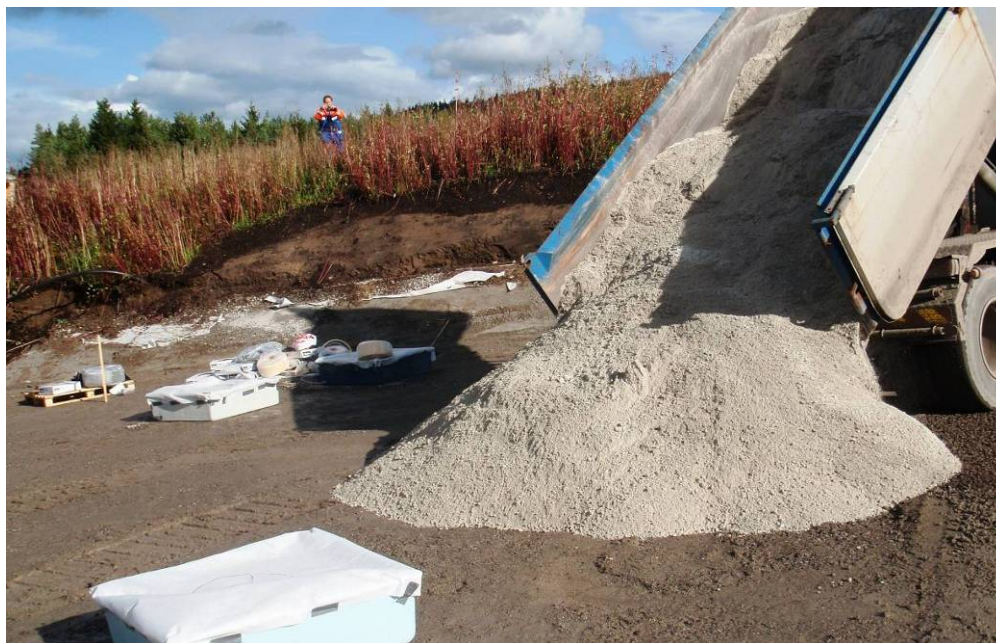
Figur 17 Tömning av slagg från dumpern inför utläggning av tätskiktet
