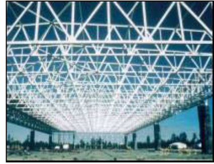
Figur 21 Ett fackverk tillverkat av kolstål. Källa: SBI, Stockholm
