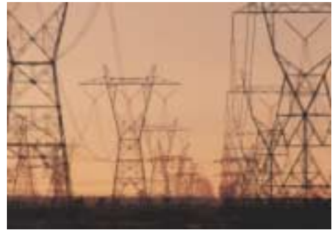
Figur 18 Högspänningsledningar i renaluminium. Källa: Svenskt Aluminium
