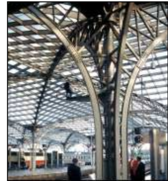
Figur 22 Svetsad byggnadskonstruktion. Källa: SBI, Stockholm
