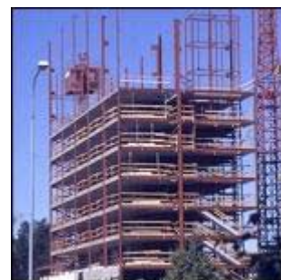
Figur 66 Flervåningsbyggnad där den bärande konstruktionen är i stål.
