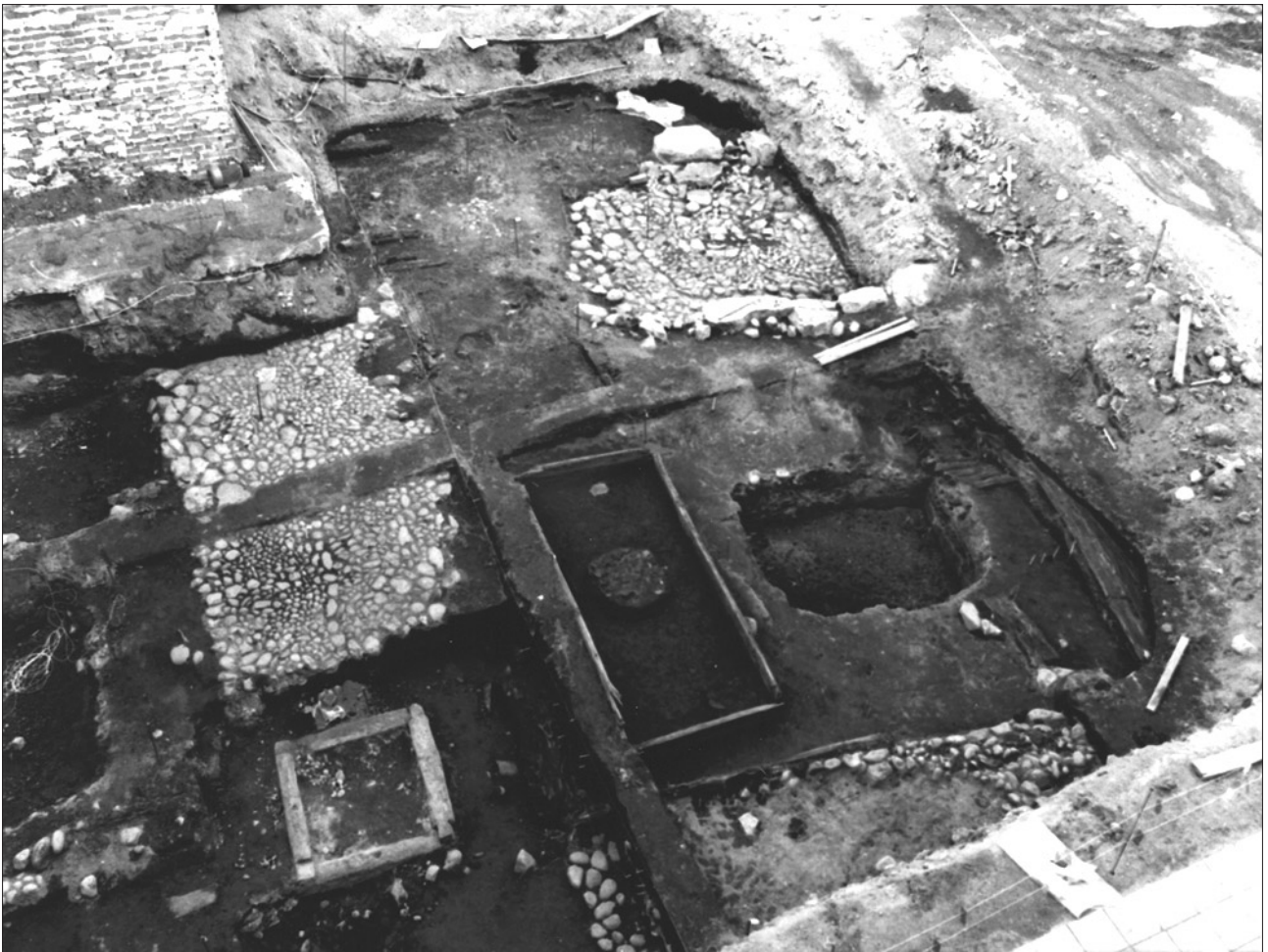
Figur 7. Det mest välbevarade urbana gjuteriet från den medeltida perioden, som hittills påträffats fanns i Uppsala under 1300- och 1400-talet. Här producerades framför allt trebensgrytor. Överst i bild syns resterna av verkstadsbuset. I den rektangulära träkonstruktionen (byggd ca 1408) grävdes gjutformarna ner inför gjutningen. Till höger därom (gropen) fanns smältugnen. (Stenläggningarna till vänster och nedtill i bilden är delar av gator). Foto: Svante Forenius, RAA.
