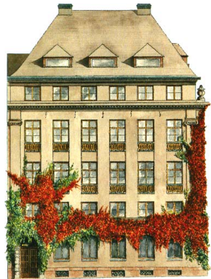
The Jernkontoret building
