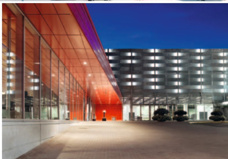
Stockholmsmässans AE-hall är byggd med varmförzinkade fasadelement.
