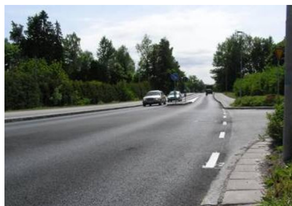
I "Stålindustrin gör mer än stål, handbok för restprodukter" finns att läsa om asfalt som innehåller slagg från Ovako. Slaggasfalt har många fördelar jämfört med traditionell asfalt, exempelvis bättre slitstyrka och lastbärande förmåga. Foto: Ovako/Kjell Pålsson.
