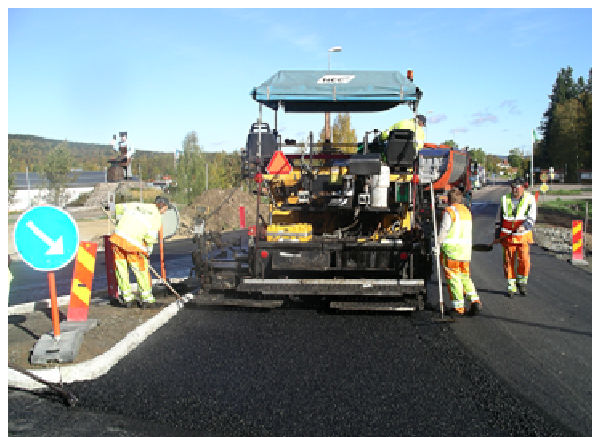
Slaggasfalt med slagg från en av Ovako's ljusbågsugnar i Smedjebacken. En av fördelarna med slaggasfalt är ökad hållbarhet. Foto: Ovako.
