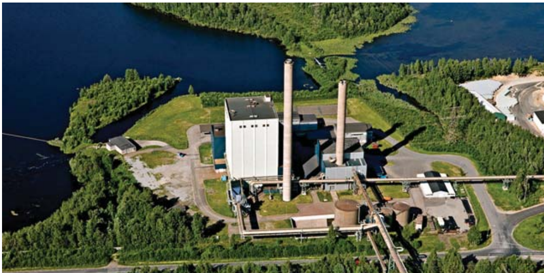
Figur 1.8. Vy över Luleå kraftvärmeverk, LUKAB, som värmer Luleå kommun
