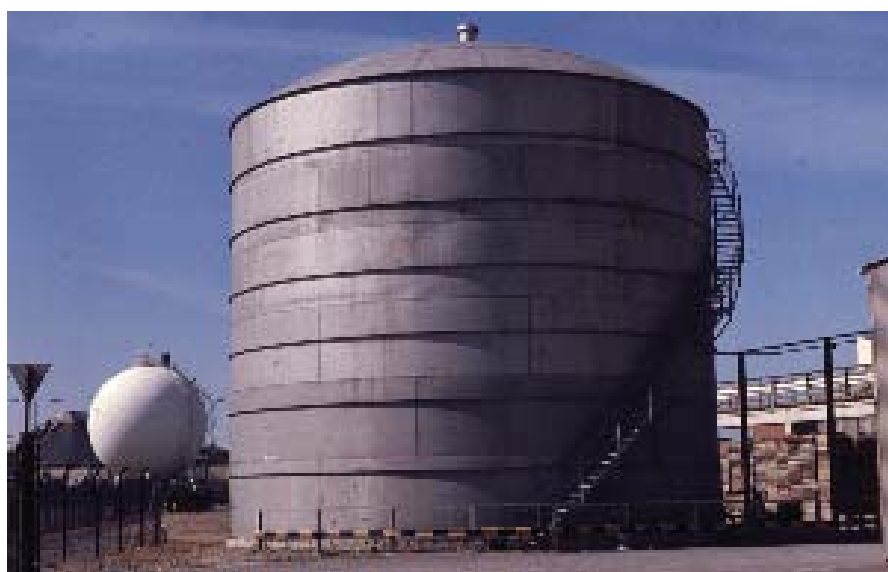
Figur 4.10. Lagringstank i rostfritt stål
